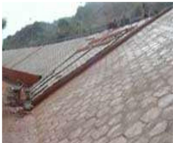
des eaux d'infiltration par la réalisation des ouvertures à la base.
