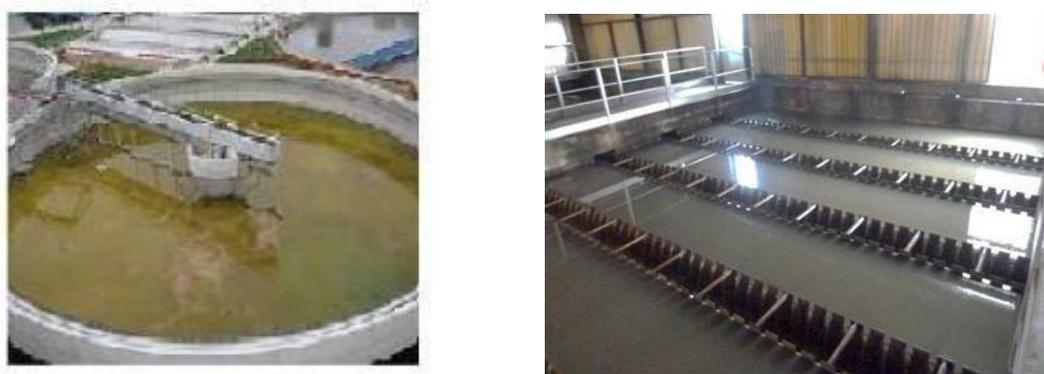
**Figure 2** : Floculation et décantation
