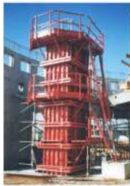
Coffrage spécifique pour poteau
