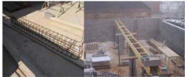
Poutres béton Coulées en place : ferrailage (cage d'armature à gauche) et coffrage (à droite)
