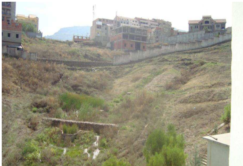
Glissement des argiles gorgées d'eau
