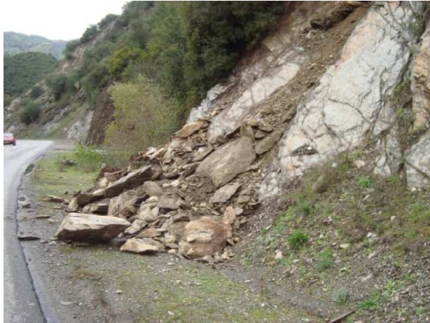
Ecroulement de blocs rocheux sous l'effet de la pente
