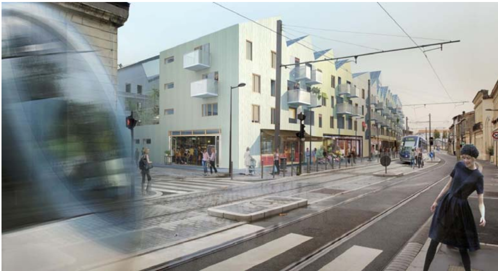
192 logements en accession: vue de la rue Achard
