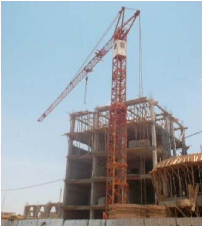
Grue à tour
